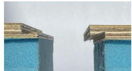
Das Profil ist in der Länge durch eine Schwalbenschwanzverbindung unendlich verlängerbar. Fotos: Ammerland Holzwaren
